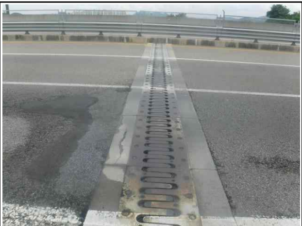
향남방향 신축이음 전경
