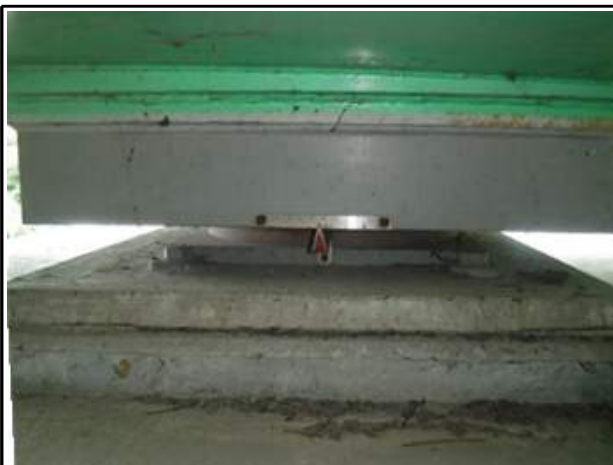
발안IC방향 교량받침 전경
