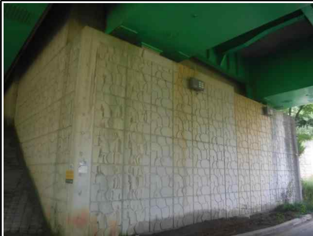
향남방향 교대 전경
