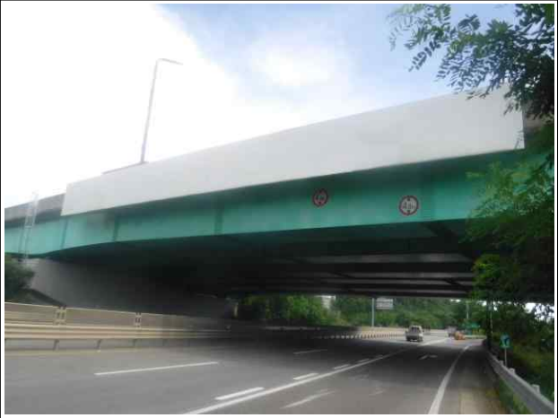
향남방향 Steel Box Girder 외부 전경
