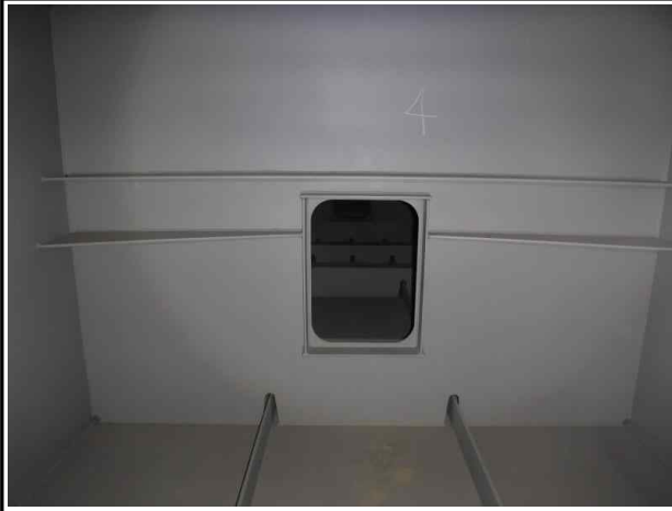
발안IC방향 Steel Box Girder 내부 전경
