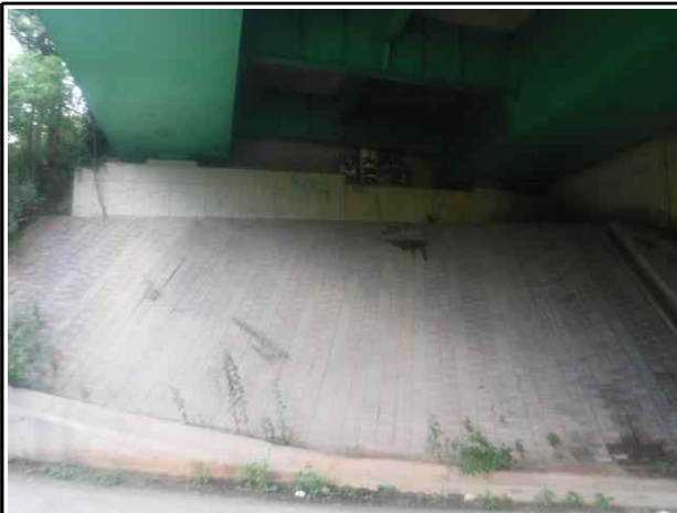
발안IC방향 교대 전경
