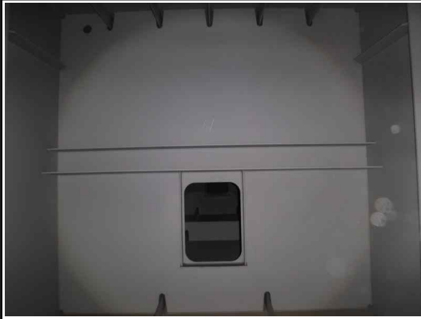
향남방향 Steel Box Girder 내부 전경
