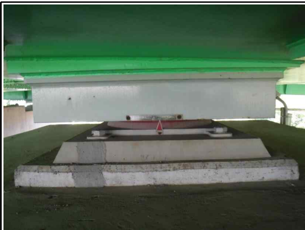
향남방향 교량받침 전경
