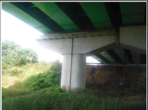
발안IC방향 교각 전경
