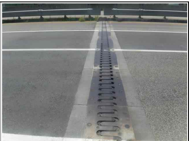
발안IC방향 신축이음 전경
