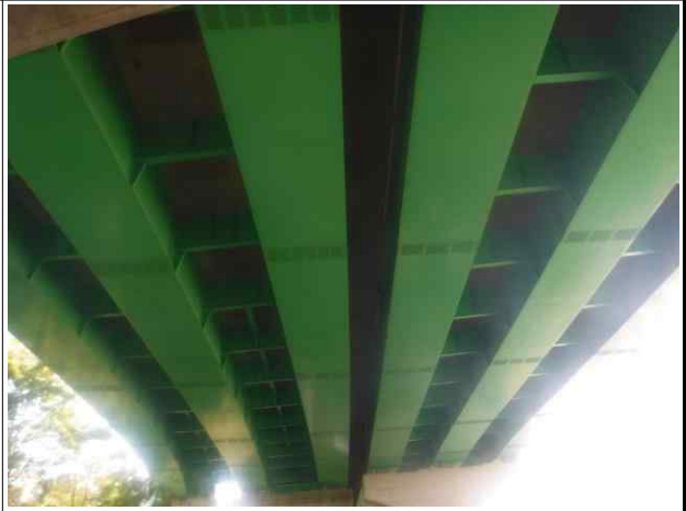
발안IC방향 Steel Box Girder 외부 전경
